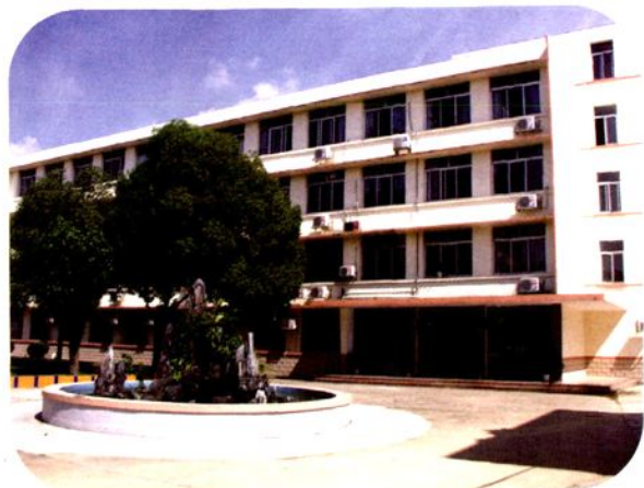
广西兽医研究所科研大楼外景
