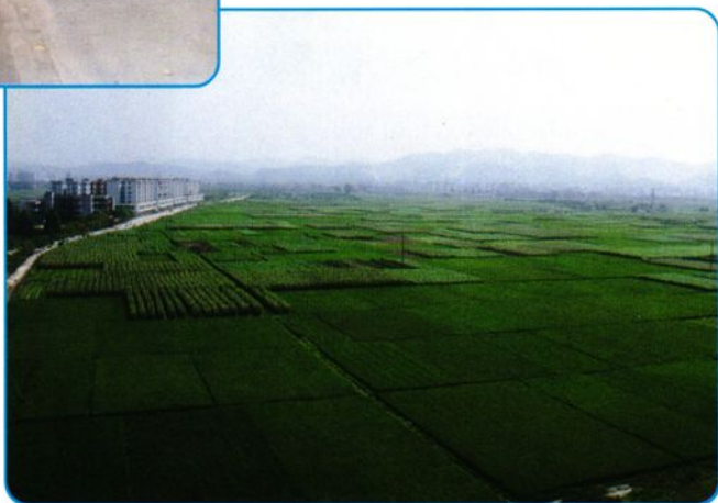
新建的龙兴公路穿过平畴绿野 横贯东西
