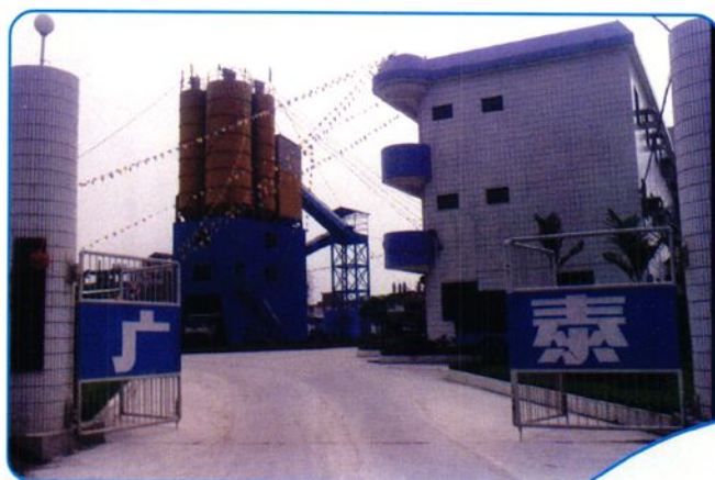
广泰混凝土公司
