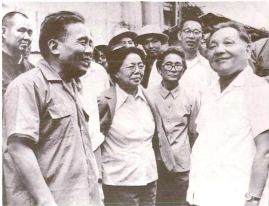
邓小平同志视察葛洲坝工地
