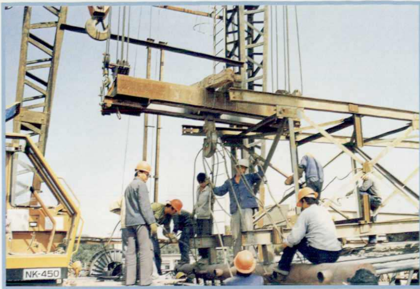
热电厂一期工程锅炉安 装施工现场
