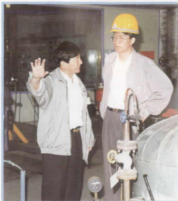
运行分场领导向副厂长刘伟（右一）汇报设备运行情况
