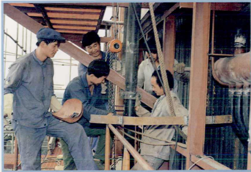
热电厂二期工程锅炉安 装施工现场
