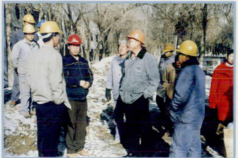
热电厂副厂长殷育才（中）、 刘伟（左前一）深入施工现场看望 热网管道安装工人
