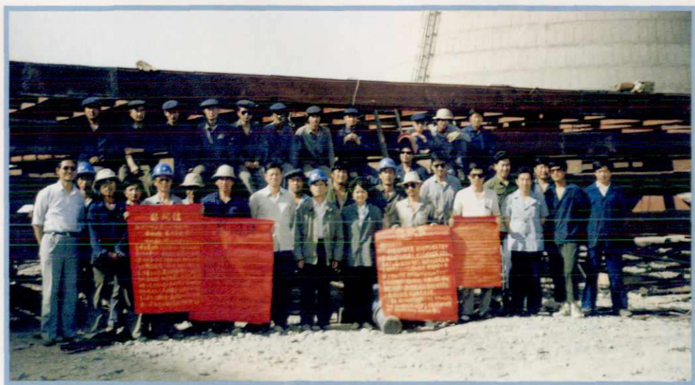
热电厂机关领导慰问4号锅炉安装队
