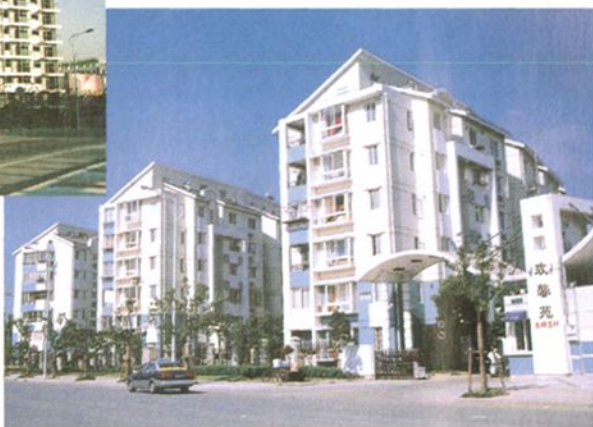
上海浦东金三角房地产实业公司开发建设的“广兰名苑”与“玫瑰苑”住宅小区
