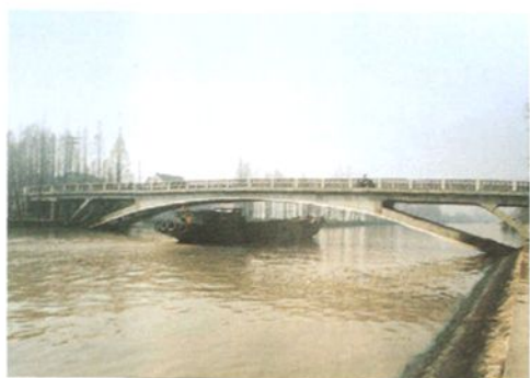
新盛境内之川杨河新华大桥
