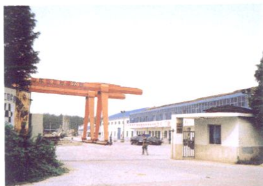
上海华玉混凝土构件厂
