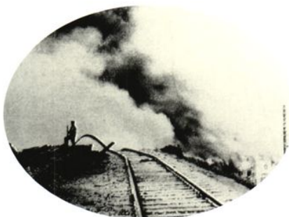
线路设备遭到严重破坏
