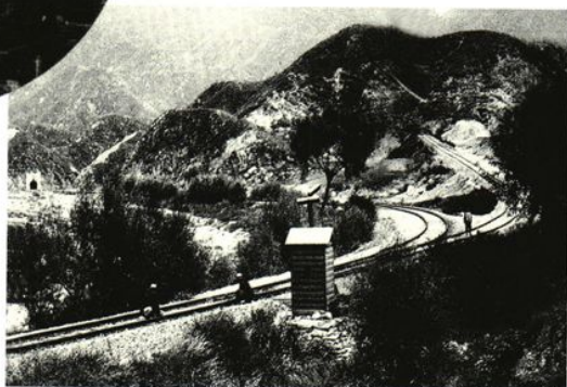
为保证下坡方向的行車安全，在青龙桥与南口间的各会让站建有避难线，以防列车溜逸失控造成事故（1909年）。
