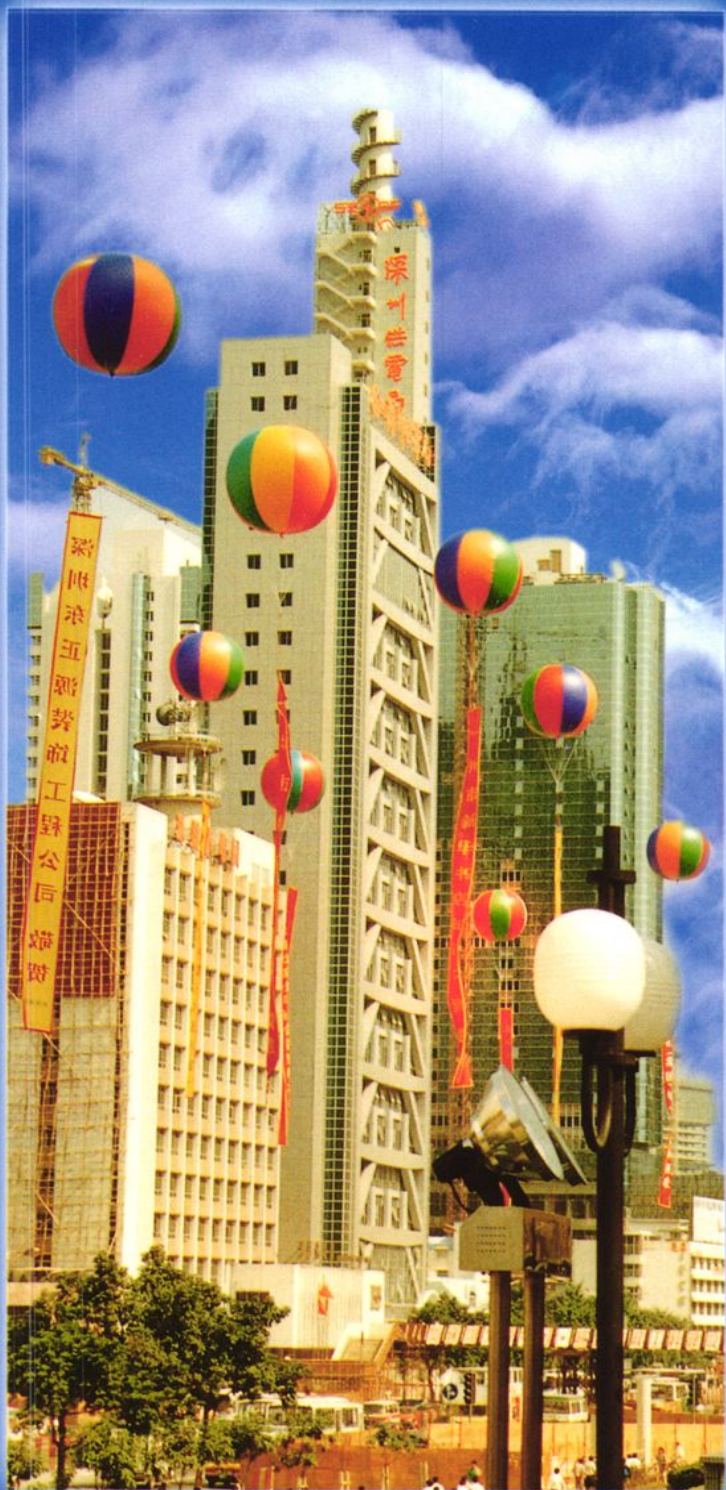
深圳电力调度综合大楼
