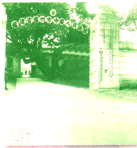
福州市中级人民法院旧址
