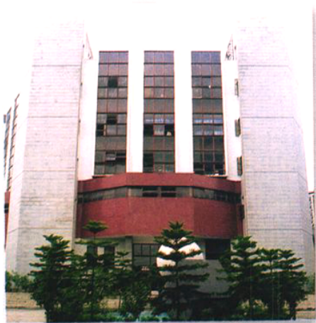
福州中院审判大楼
