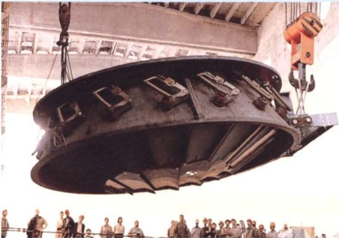
1997年水电十局承担浙汇丽水玉溪水电站贯流式机组安装
