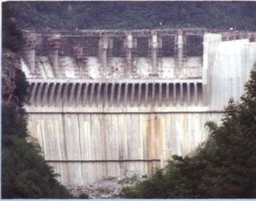
2006年建成的安徽流波水电站三芯圆单曲薄壁碾压混凝土拱坝工程，坝高70.1米
