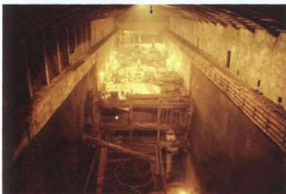
1992年建成的自重50吨，载重250吨的阿坝州太平驿电站地下厂房岩锚梁，获国家电力公司科技进步奖
