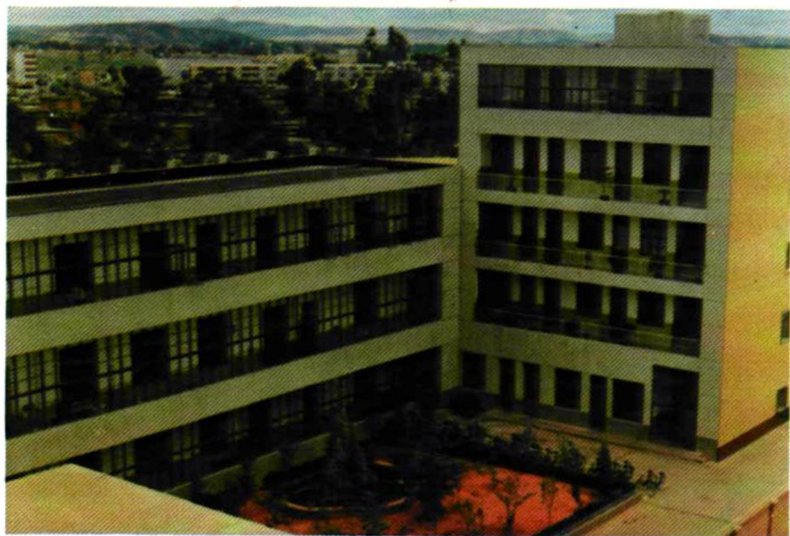
◇ 程控机房大楼
