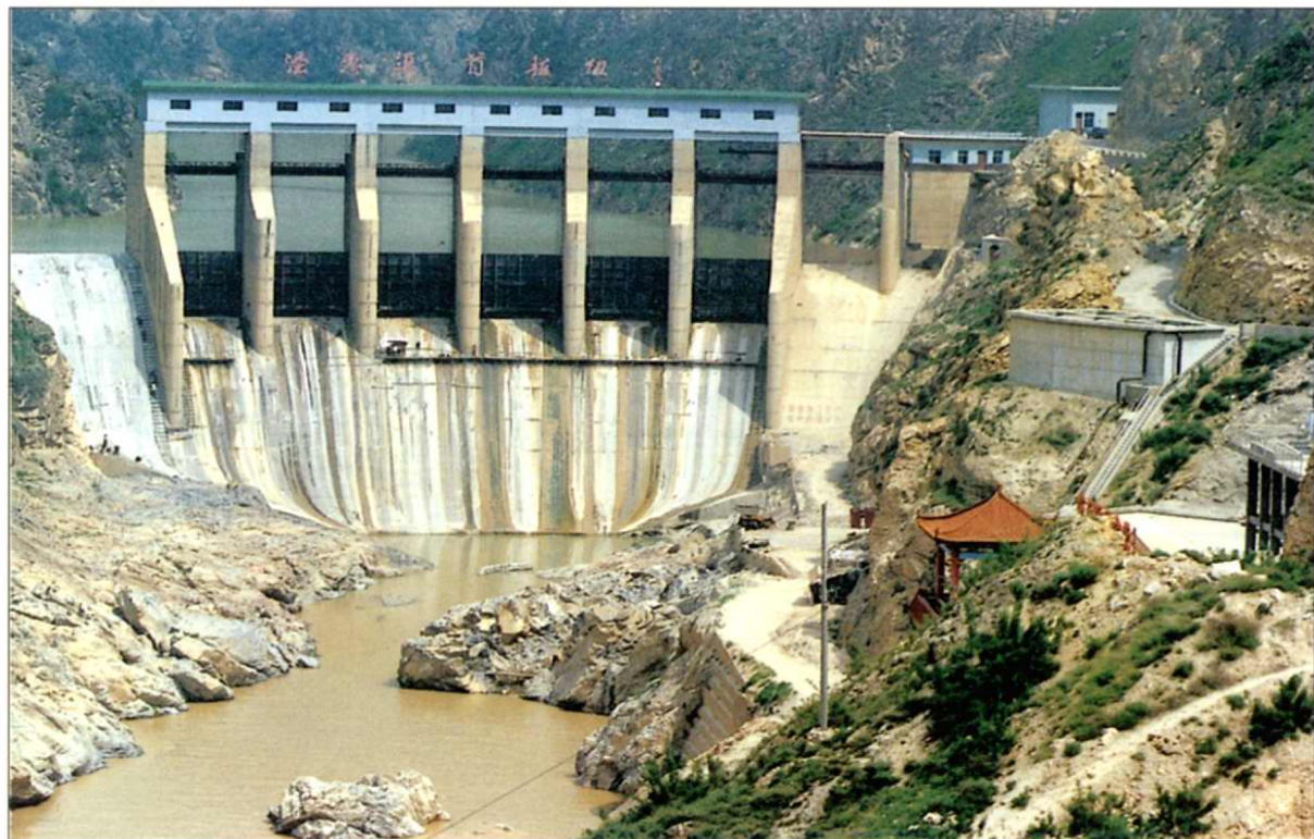
泾惠渠渠首工程
