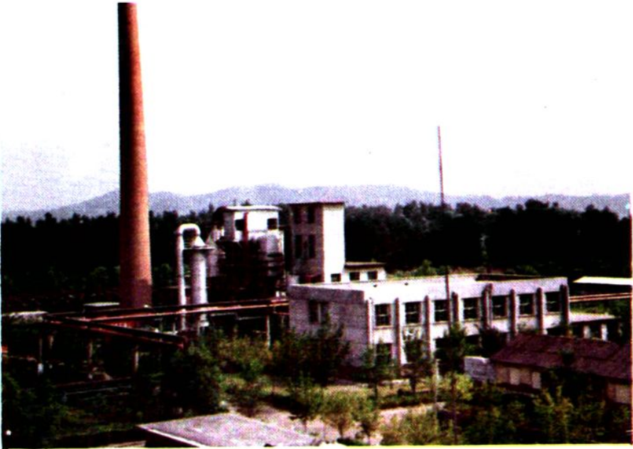
污泥焚烧装置
