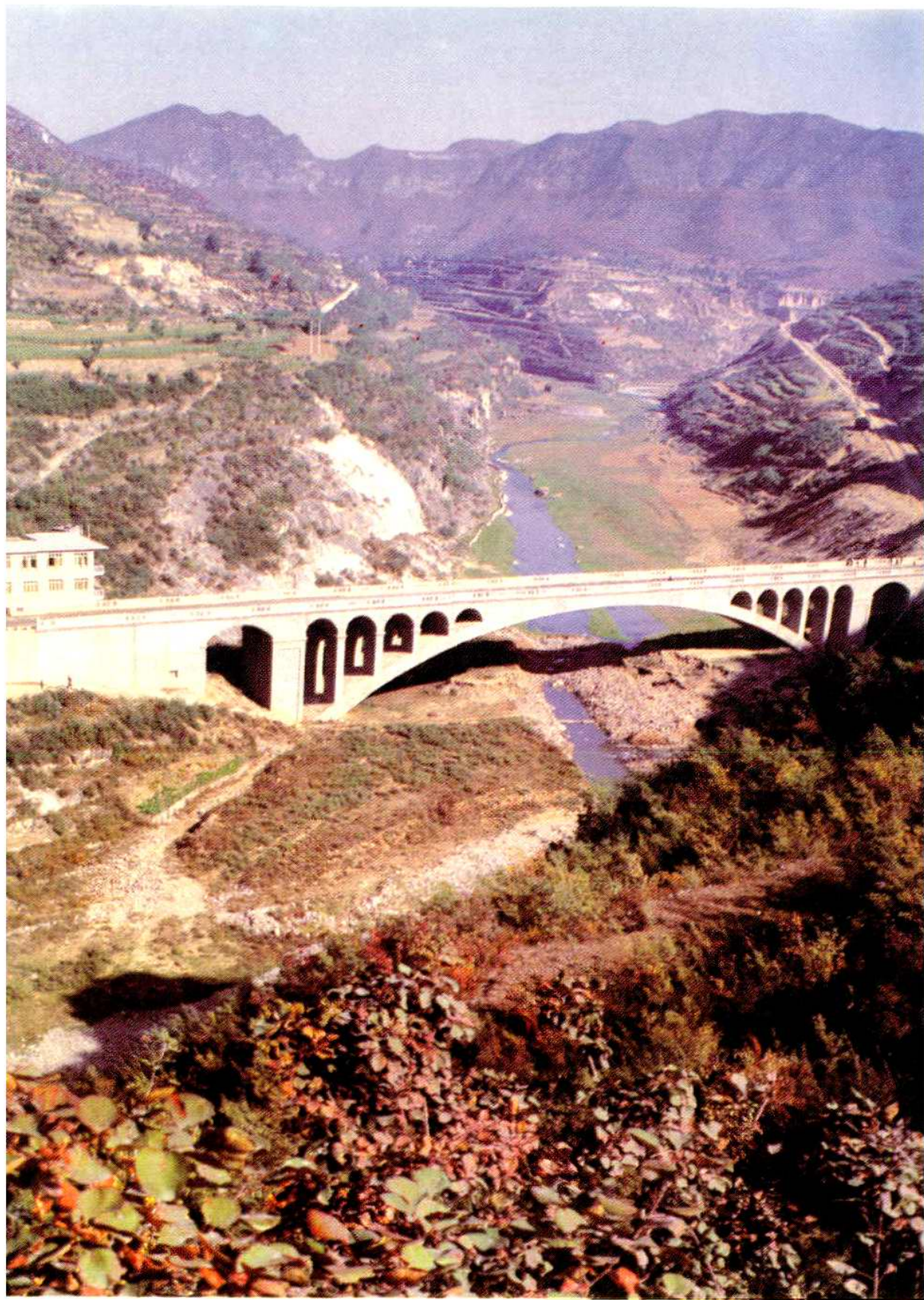
晋张公路丹河大桥
