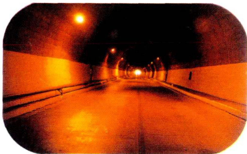
晋阳高速公路隧道
