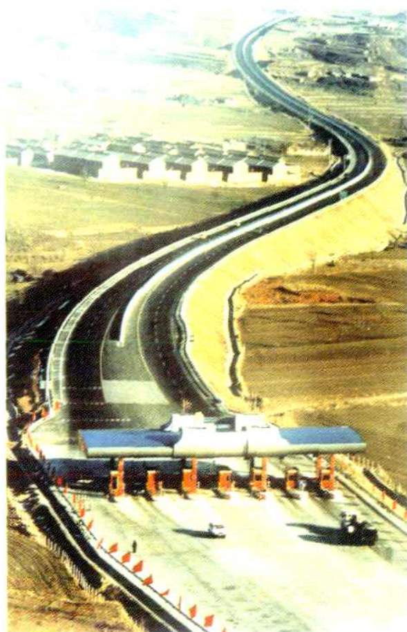
晋阳高速公路晋城收费站
