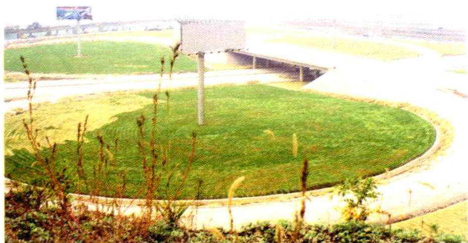
在建的晋焦高速公路东上庄立交桥
