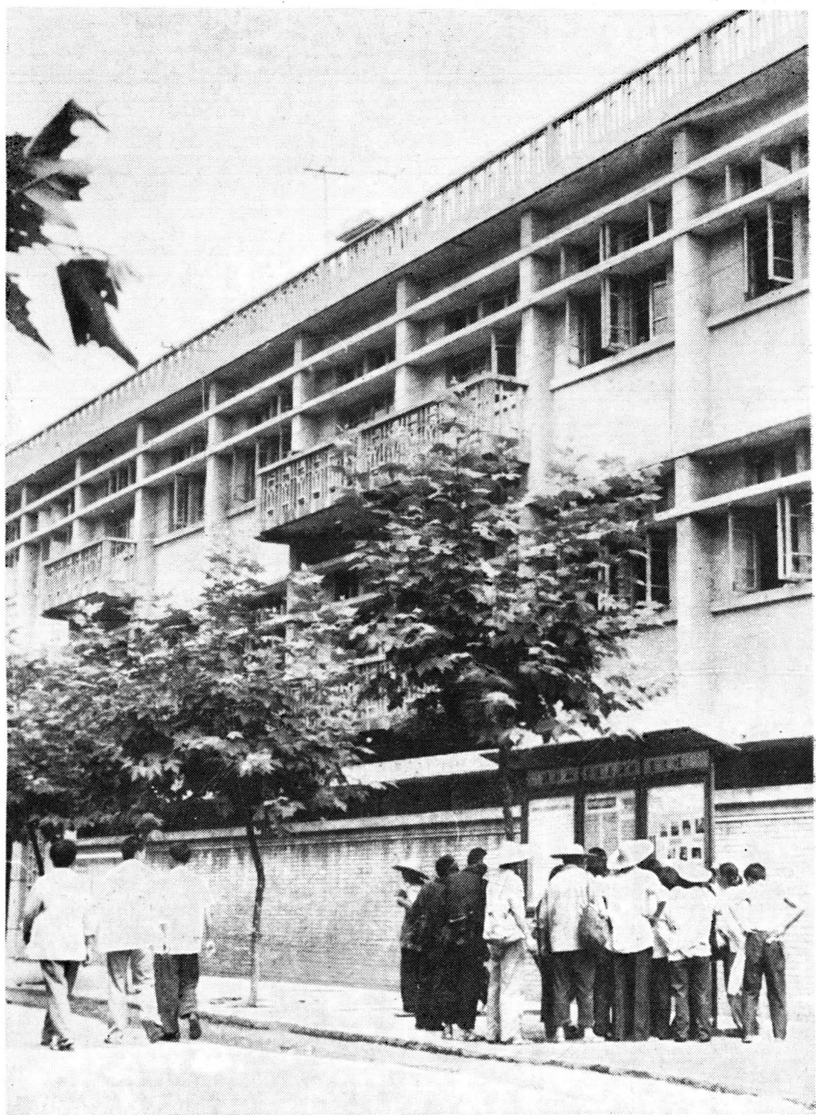
新都县卫生局办公楼
