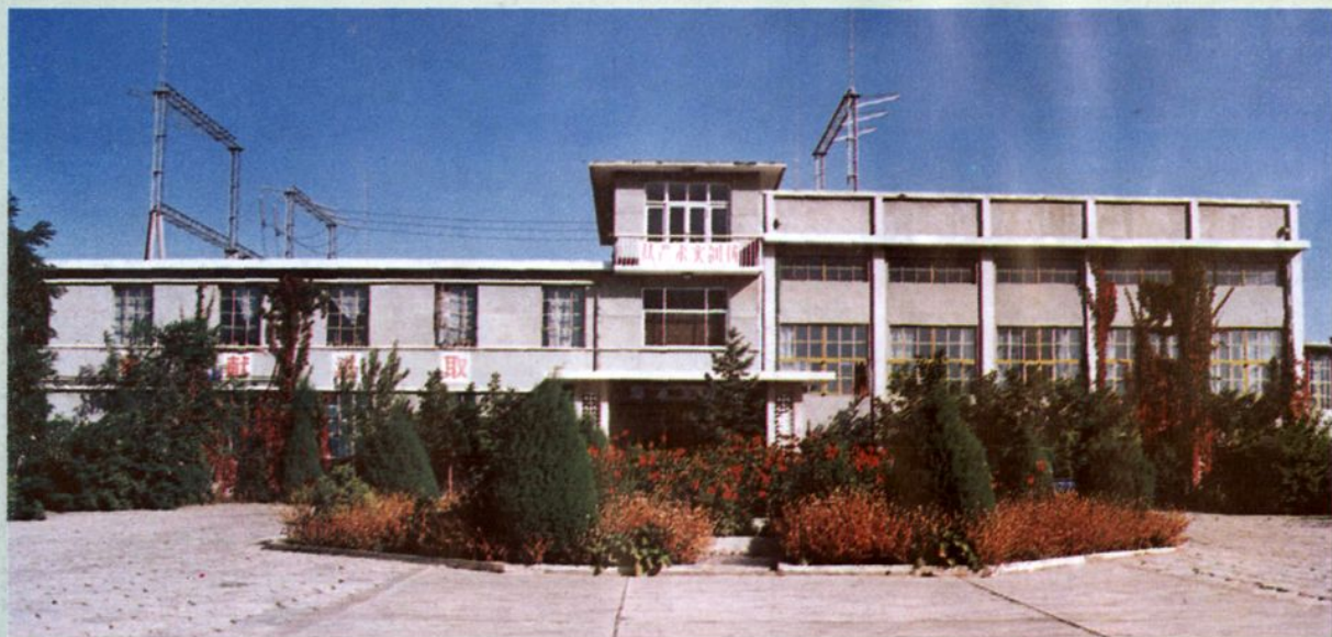
阳高 220 千伏变电站
