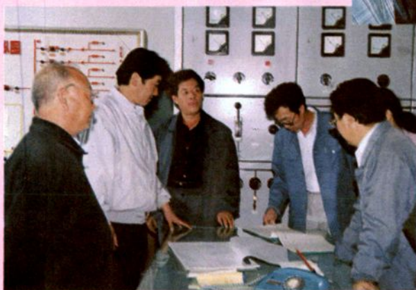
山西省电力局副局长王若维(左二)视察城关110千伏变电站
