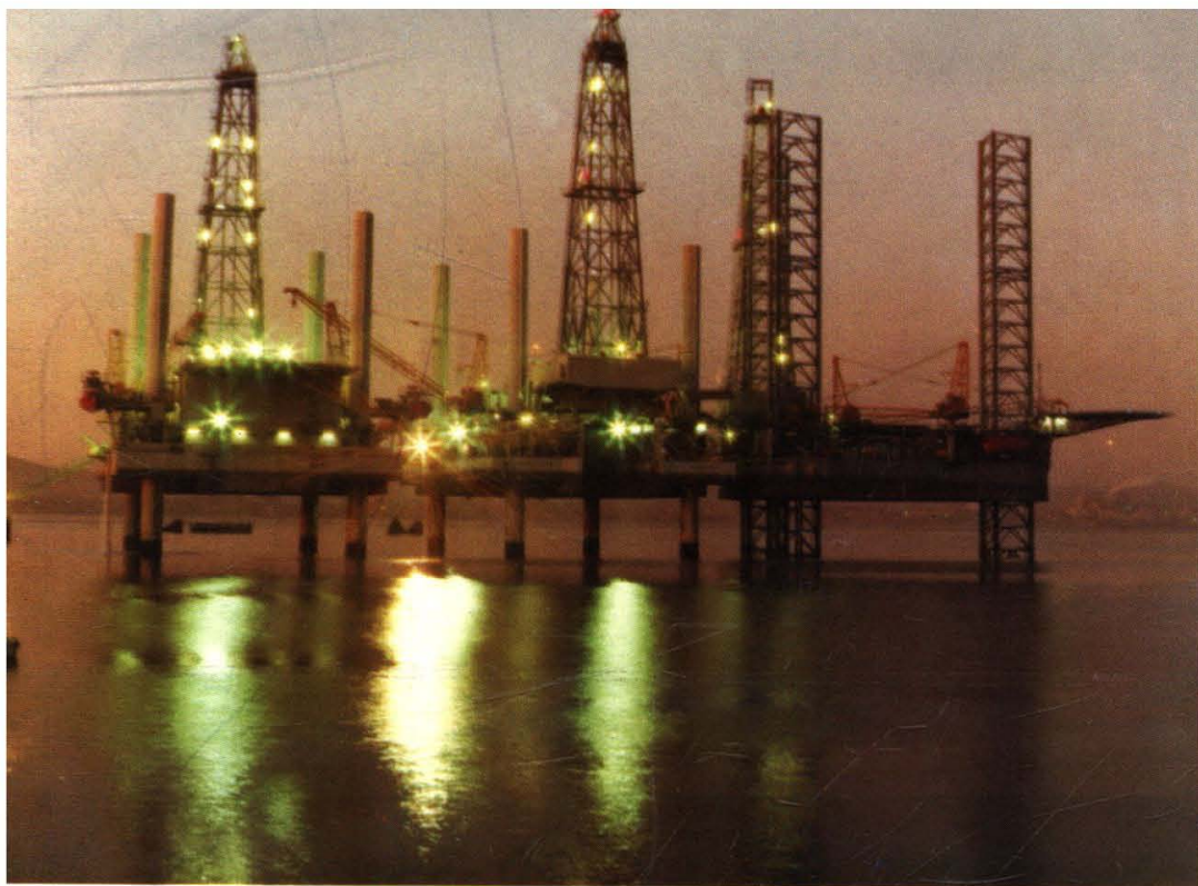
1982年，船舶检验局天津办事处与美国船级社合作检验的渤海埕北油田海上导管架固定平台。
