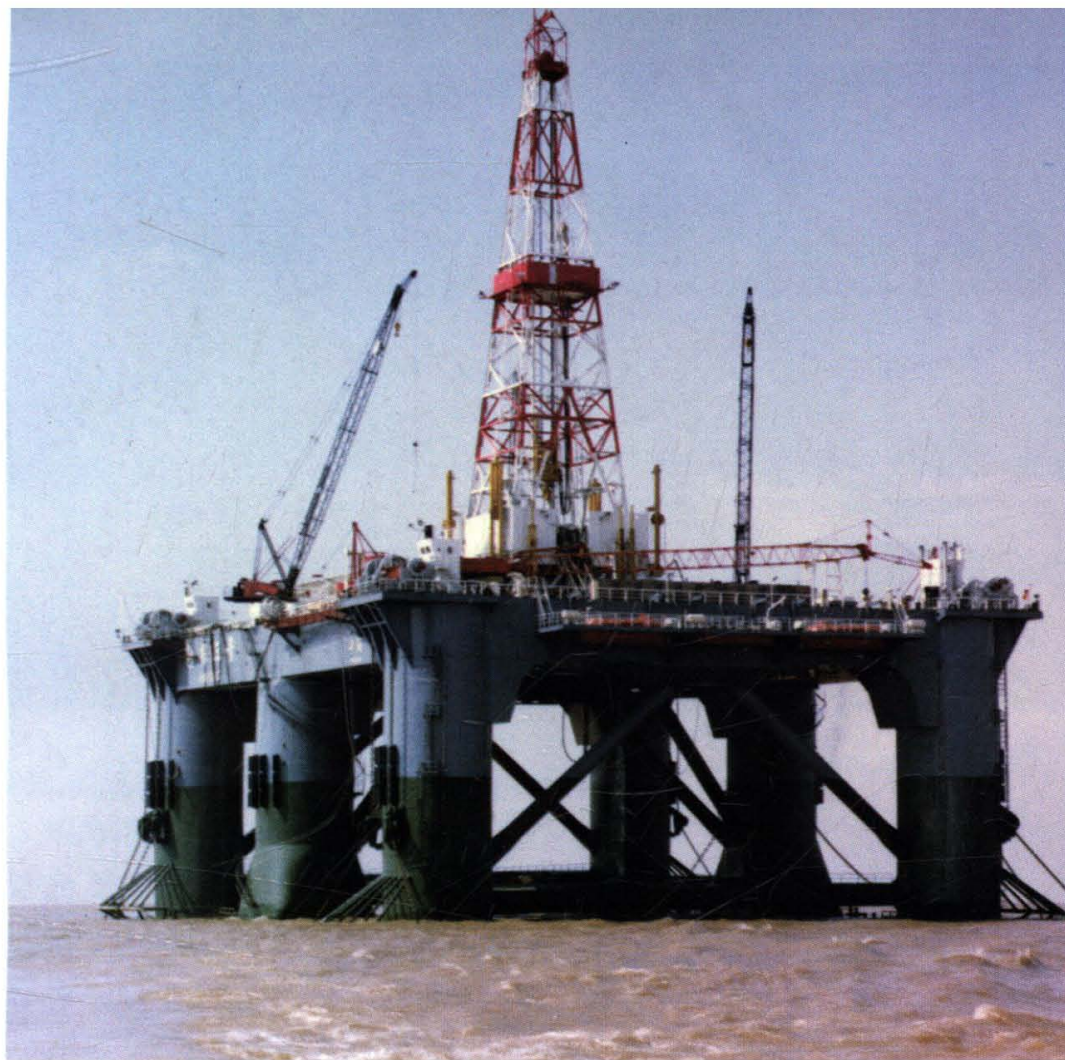
1979 年，船舶检验局上海办事处执行建造检验与发证的中国第一座半潜式钻井平台“勘探三号”。
