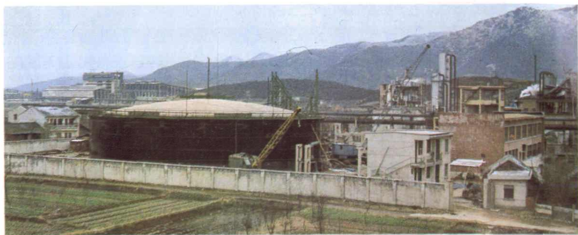
正在兴建中的 20000m 3 煤气柜
