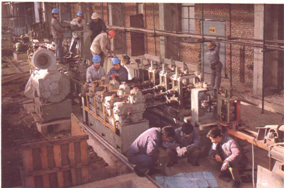
修建部工人 安装钢管分厂 焊管车间设备
