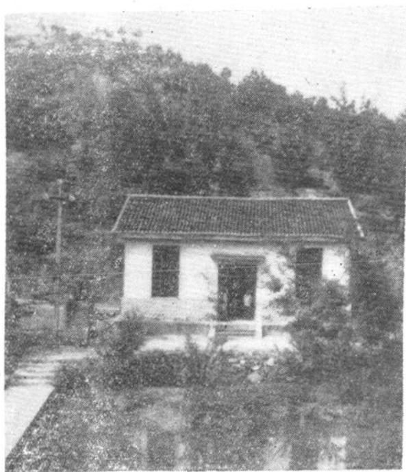
△ 银坑镇大排水电站
