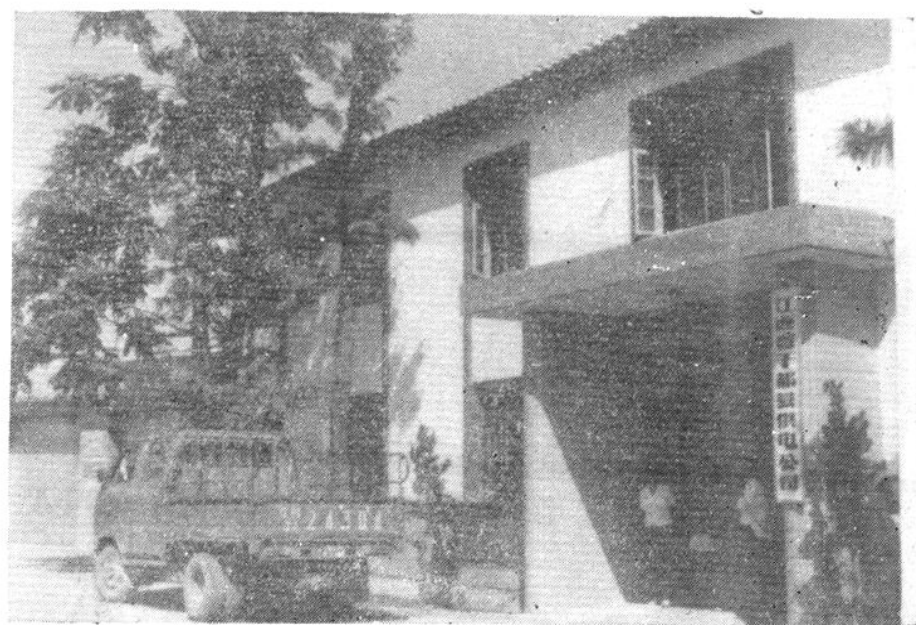
◁ 于都县供电公司
