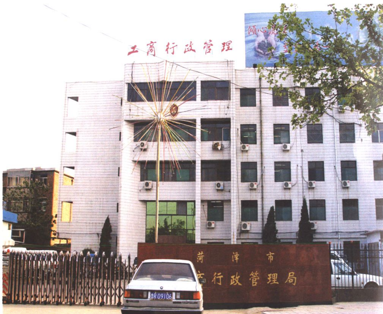
1993 - 2005 年的菏泽市工商局机关办公楼
