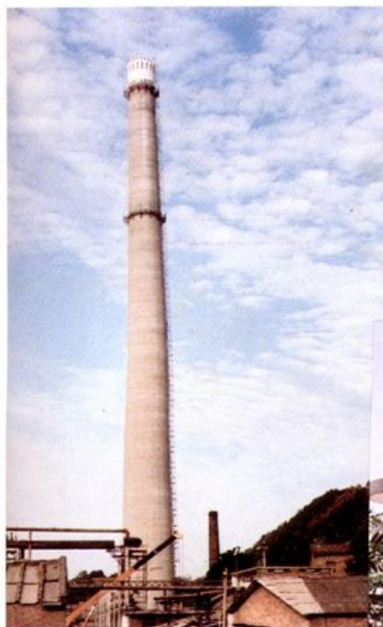
▲ 采用滑模工艺施工的我国第一座小口径的烟囱
