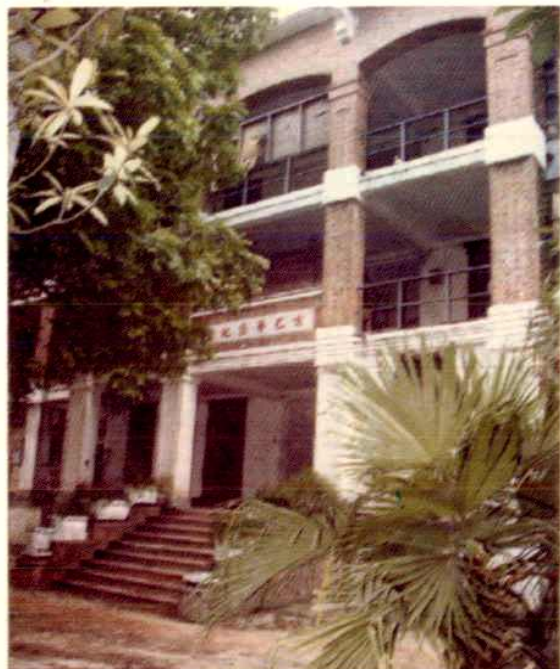
培正中学古巴华侨纪念堂(1924年 建成，摄于1991年，1994年拆除 建林炳炎基金教学大楼)
