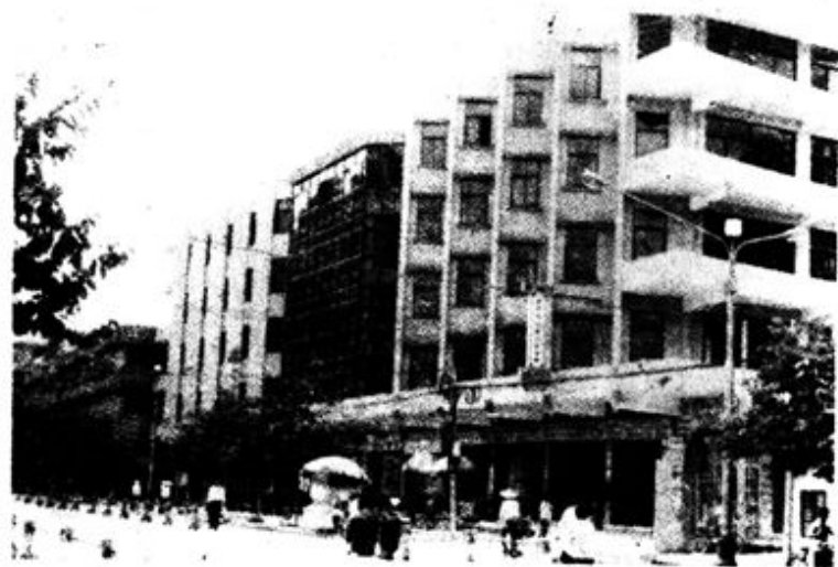
县建设委员会、县房产管理局综合办公大楼
