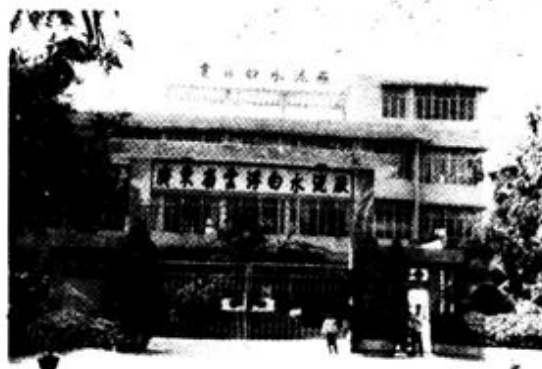
白水泥厂办公楼
