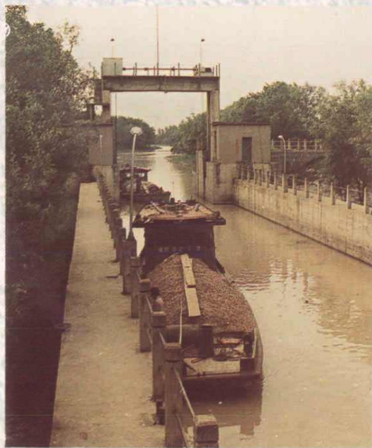
乌江枢纽船闸
