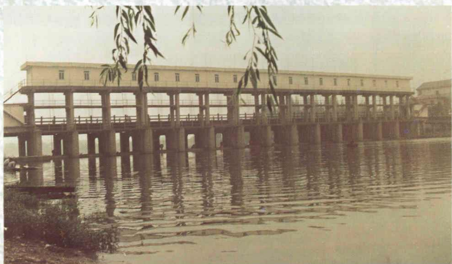
汉河集枢纽节制闸
