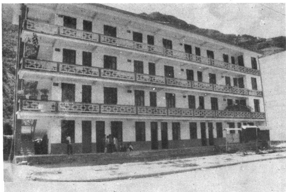
县妇幼保健站工作大楼
