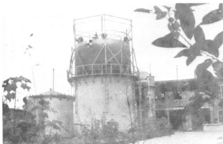
彭县灯泡厂煤气站。
