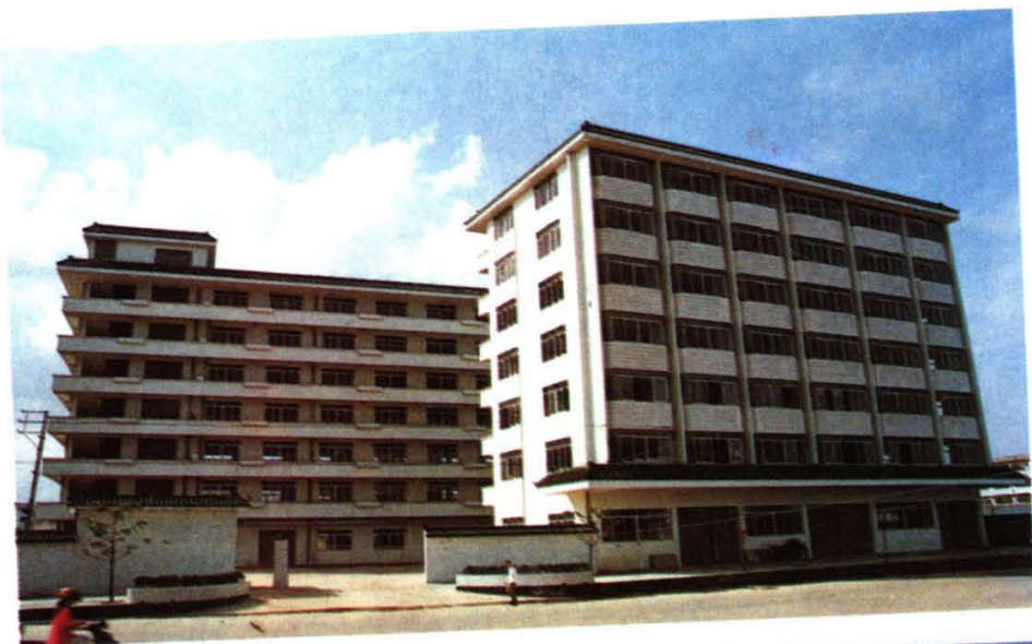
蓬江区沙仔尾办事处工业大楼
