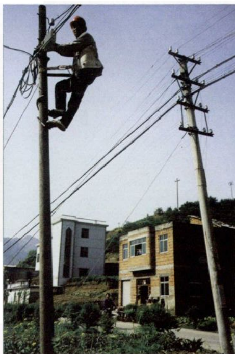
外线工架设光缆
