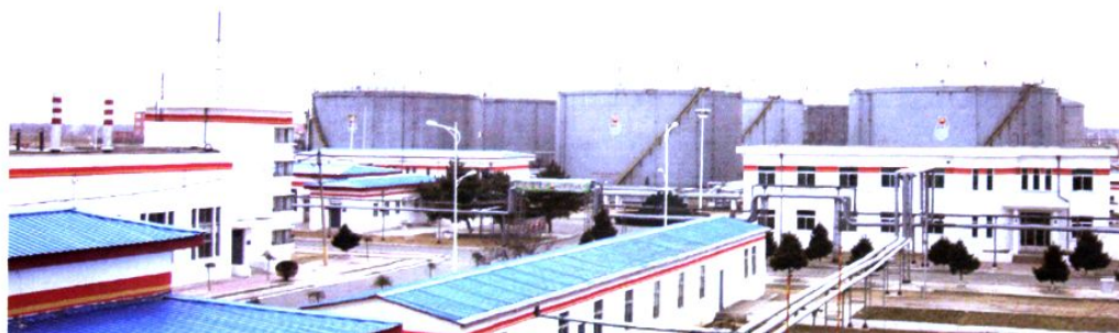
沈阳采油厂油气集中 处理联合作业站
