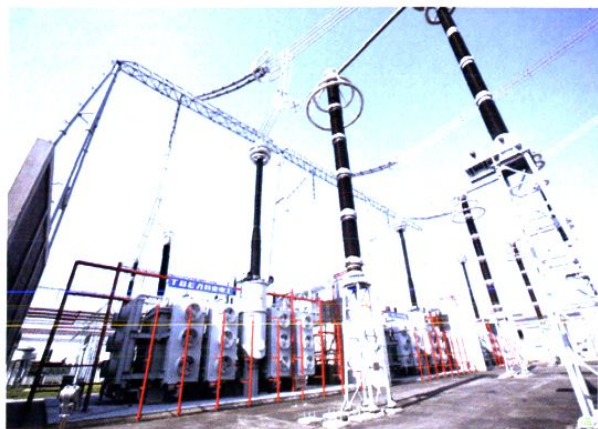
特变电工沈阳变压器集团有限公司研制的世界首台特高压交流 1000兆伏安 / 1000千伏变压器
