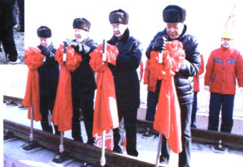
2010年12月28日，哈大铁路 客运专线全线钢轨铺通，图为有关 领导为最后一段钢轨拧紧螺丝
