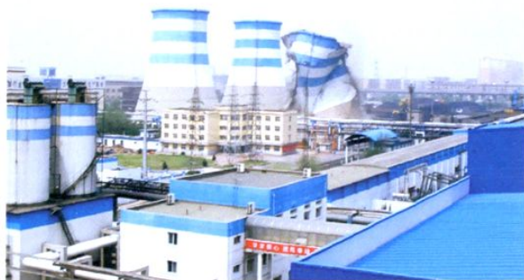
沈阳热电厂一期冷却塔拆除，标志着华电公司顺利完成“十一五”期间国家发改委制定的节能减排目标
