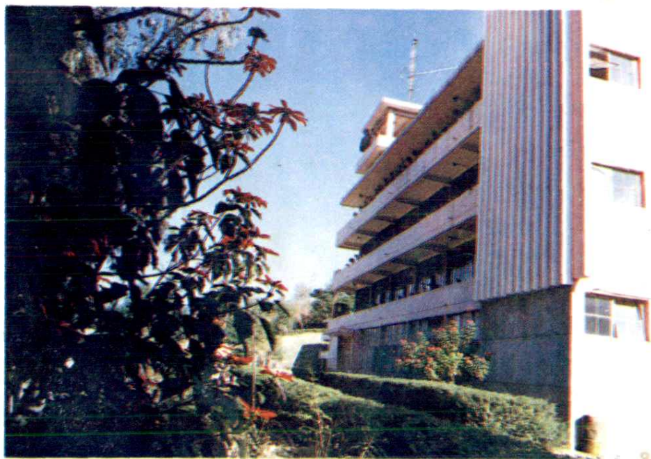
► 市电视台中心机房。
