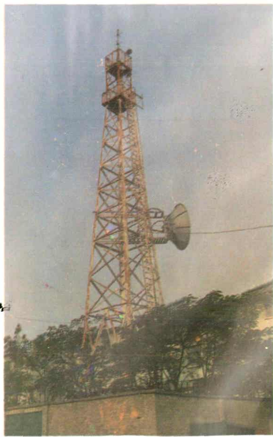
► 攀钢南山电视差转台发射台。
