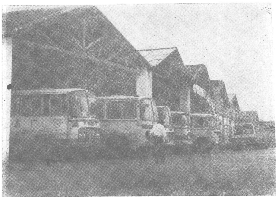
⑮ ↑ 县车站汽车修理厂车间
