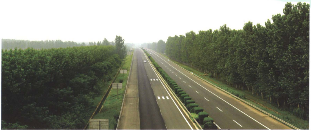
2010年，津蓟高速公路蓟县段绿化带建设工程
