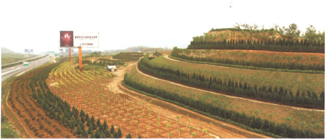
2010年，蓟平高速公路蓟县段绿化带建设工程
