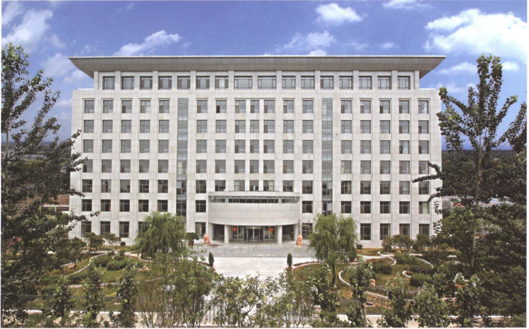
2011年12月，天津市蓟县林业局新办公大楼落成
