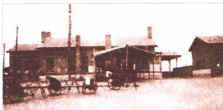
榆次西站站舍(市街一角)(1954 年)
