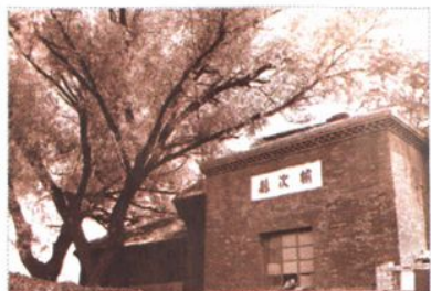
榆次县站(老西站)(建于 1934 年)
