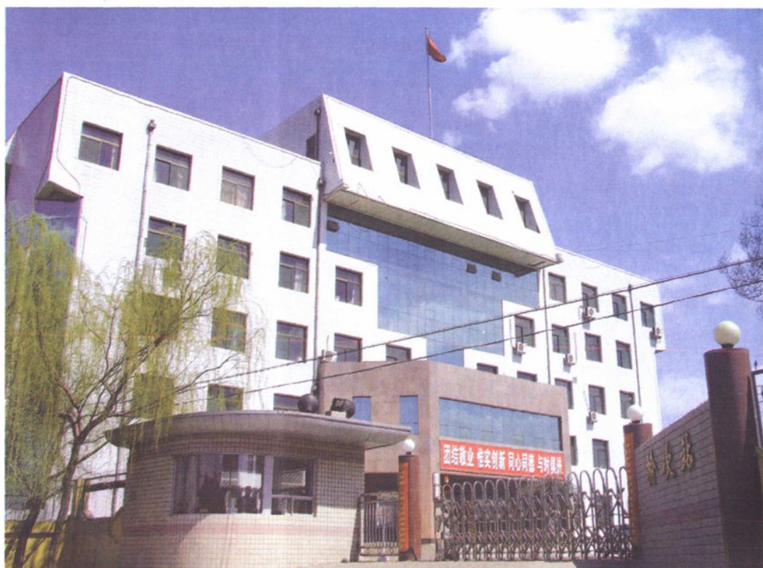
榆次站办公楼(建于1993年1月)
