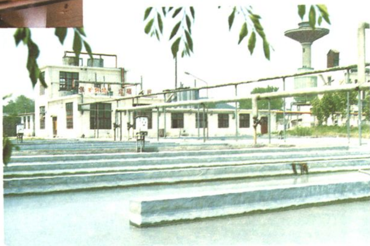
黄磷污水处理
