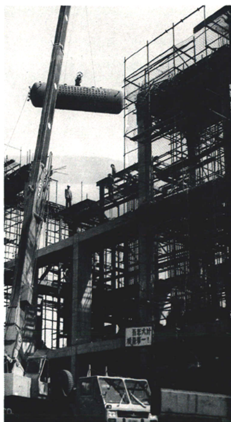
SHR20——13A型锅炉在安装中
