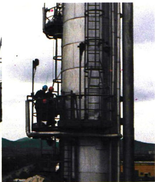
对大型压力容器进行定期检验
