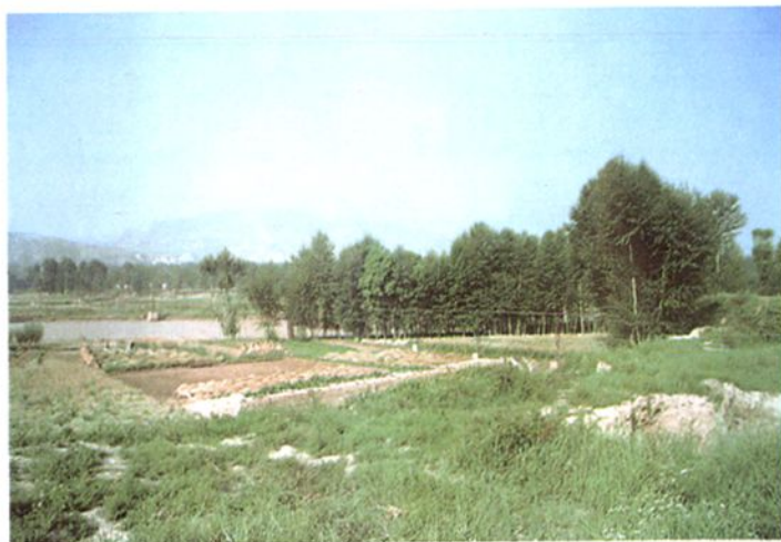
西村北水南调水利工程
