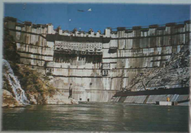
建设中的二滩水电站大坝
