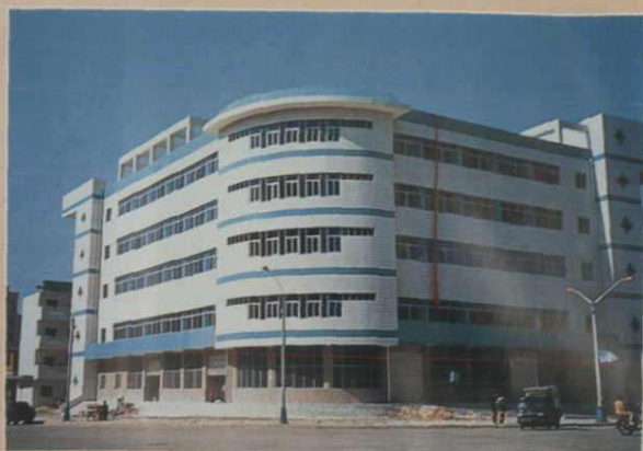
正在建设中的新县城邮电大楼
