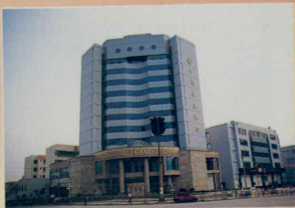
新县城农行大楼
