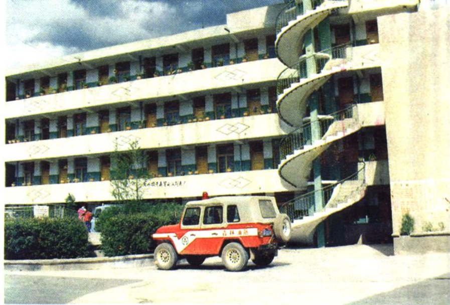
县林业局办公大楼
