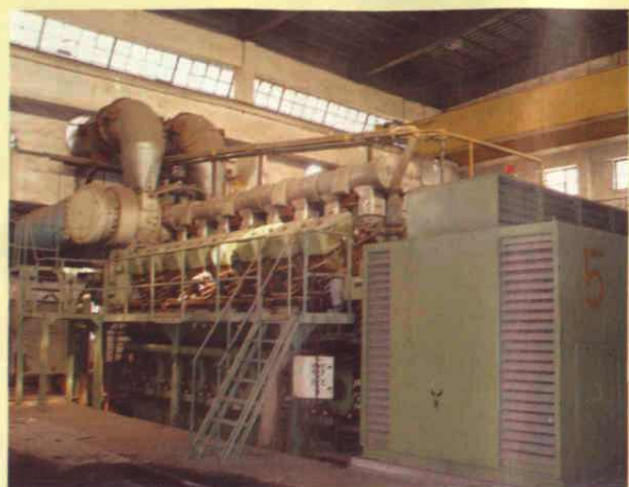
台山发电厂（1986年建成）
