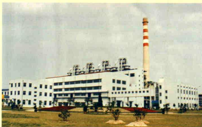
双水发电厂（1994年建成）
