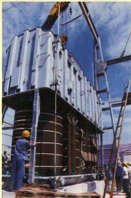
220千伏水口变电站主变吊装检查
