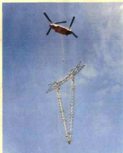
500千伏线路施工采用直升机组装铁塔
