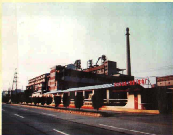
江门北街（联营）电厂（1988年建成）
