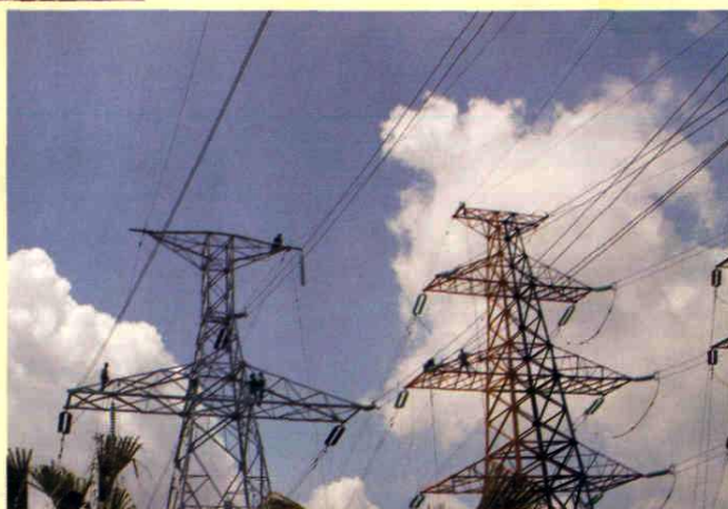
220千伏线路检修
