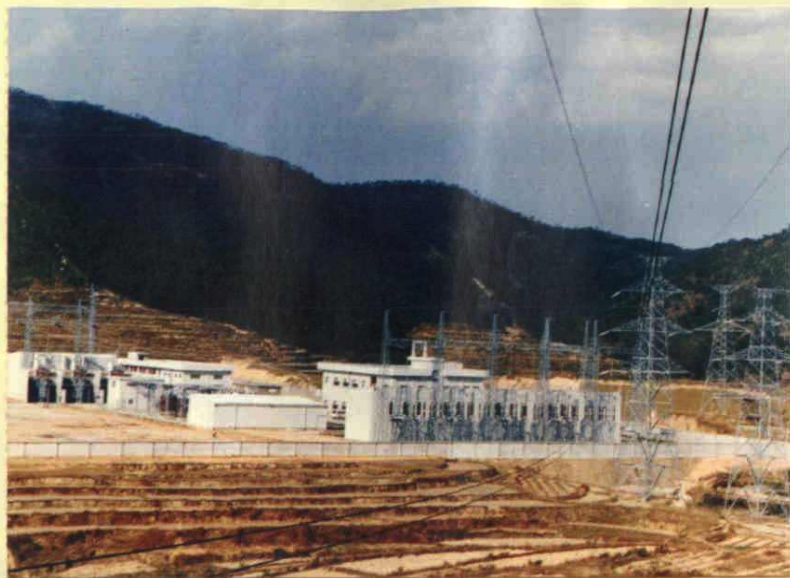
广东省第一座500千伏变电站——江门变电站（1987年建成）
