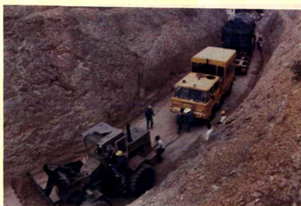
变压器运往220千伏台山变电站途中（1990年）
