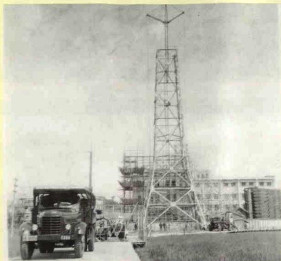
220千伏北街变电站70米微波塔施工
