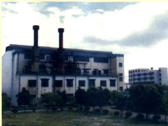
荷塘发电厂（1994年建成）
