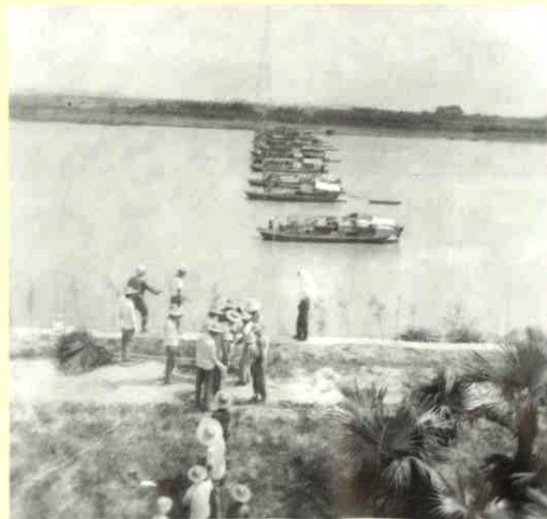
110千伏潮荷线放线施工（1981年）
