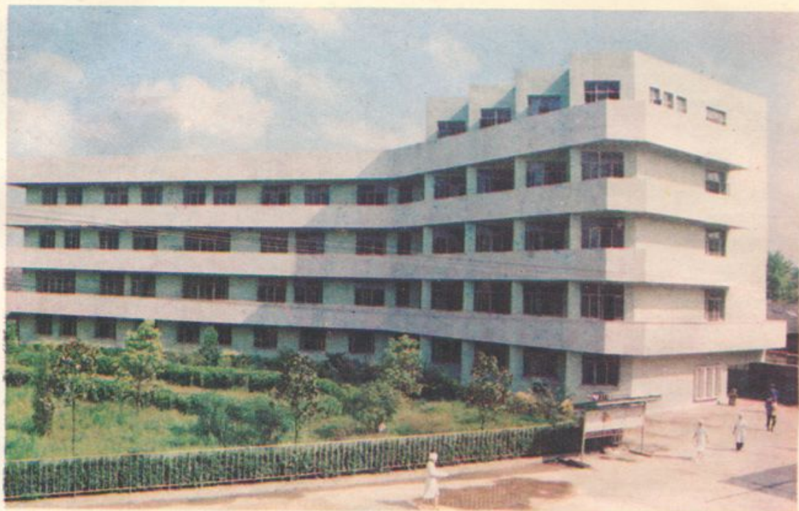
溧水县人民医院病区外科大楼
