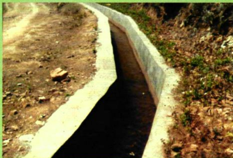
三面支砌的灌溉渠
