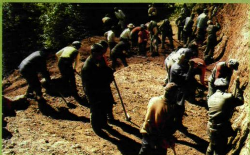
乡村公路建设
