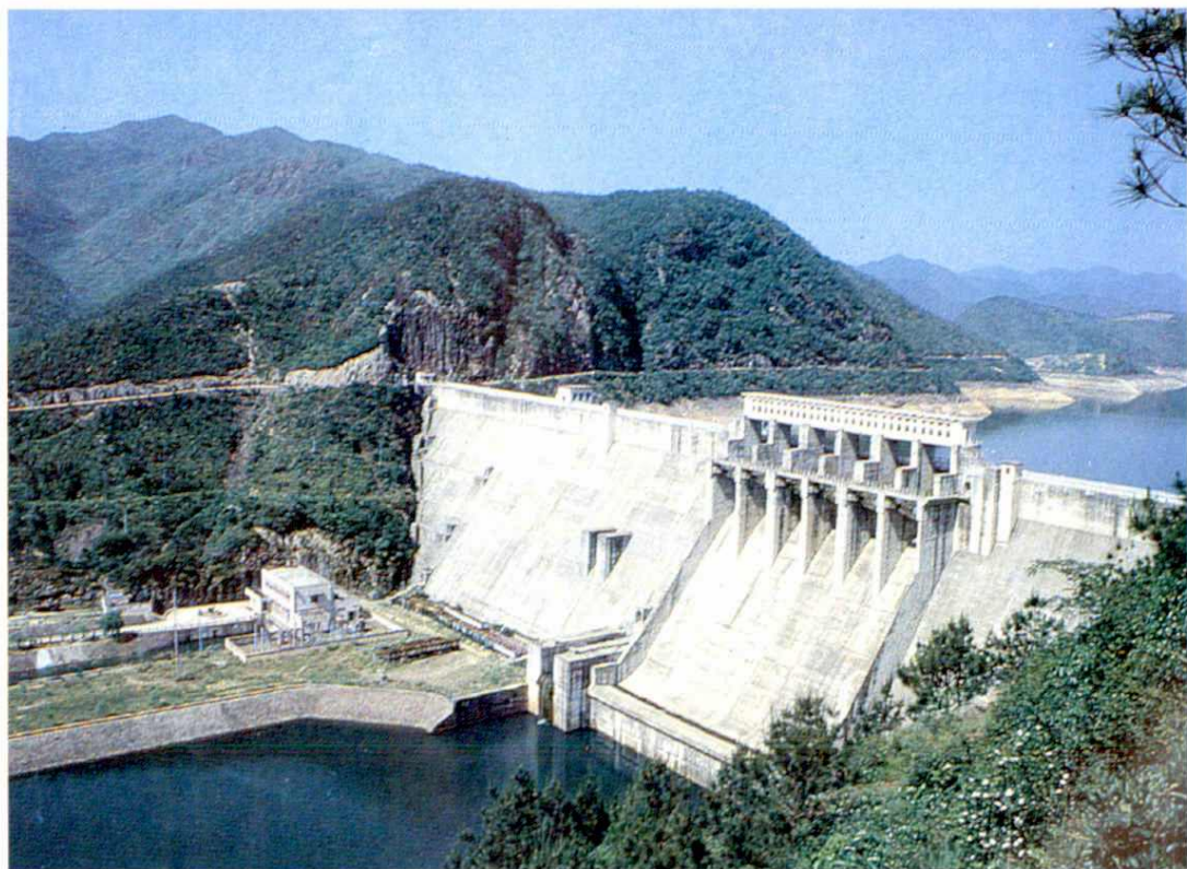
亭下水库 总库容15024万立方米，坝高76.5米，混凝土重力坝。以防洪、灌溉为主，兼发电、城市供水综合利用
