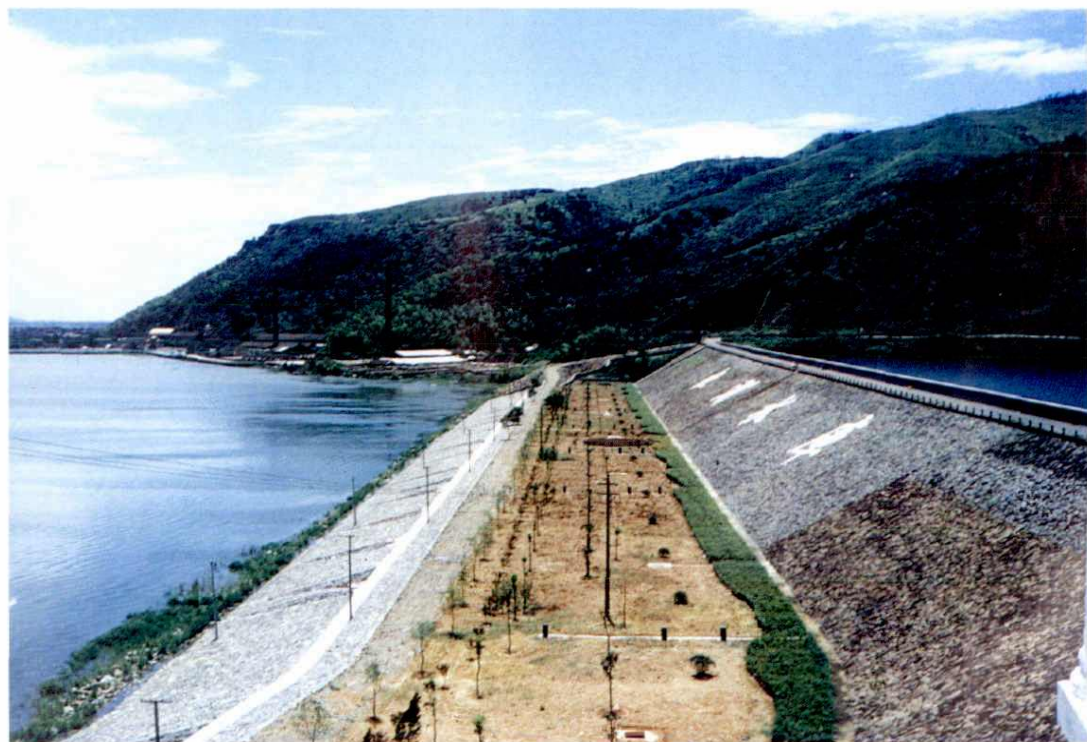
里杜湖水库 总库容2136万立方米，坝高17.5米，粘土斜墙坝，坝基为软粘土，砂井砂垫层处理
