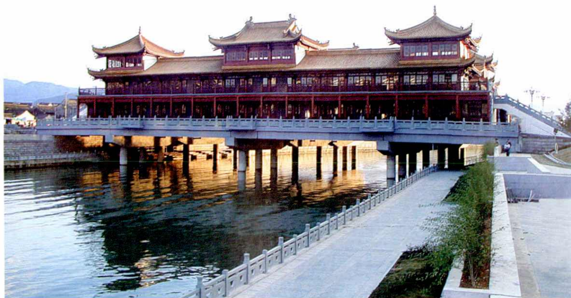
奉化市县江整治工程——廊桥
