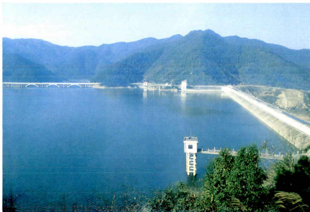
梁辉水库 总库容3152万立方米，坝高35.4米，建在深厚砂砾石基础上的混凝土面板堆石坝
