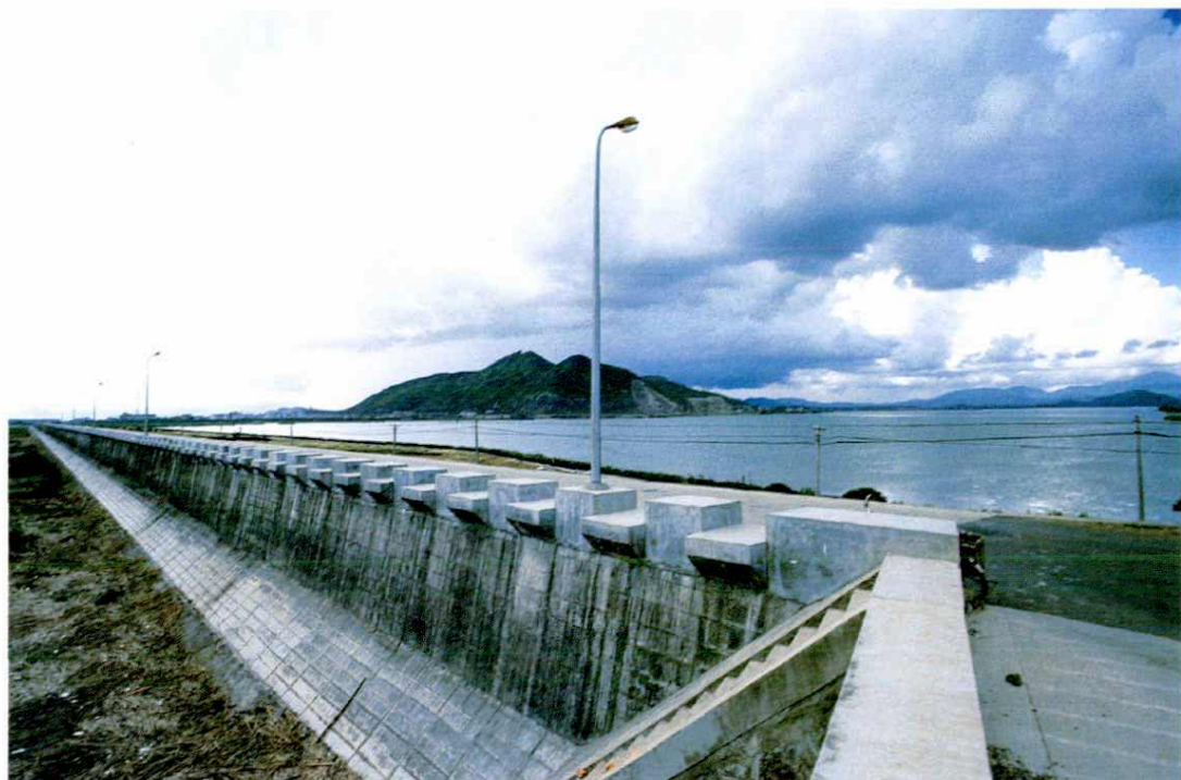
胡陈港堵港工程 大坝长1138米，主坝高16.5米，土石混合坝。总库容8172万立方米
