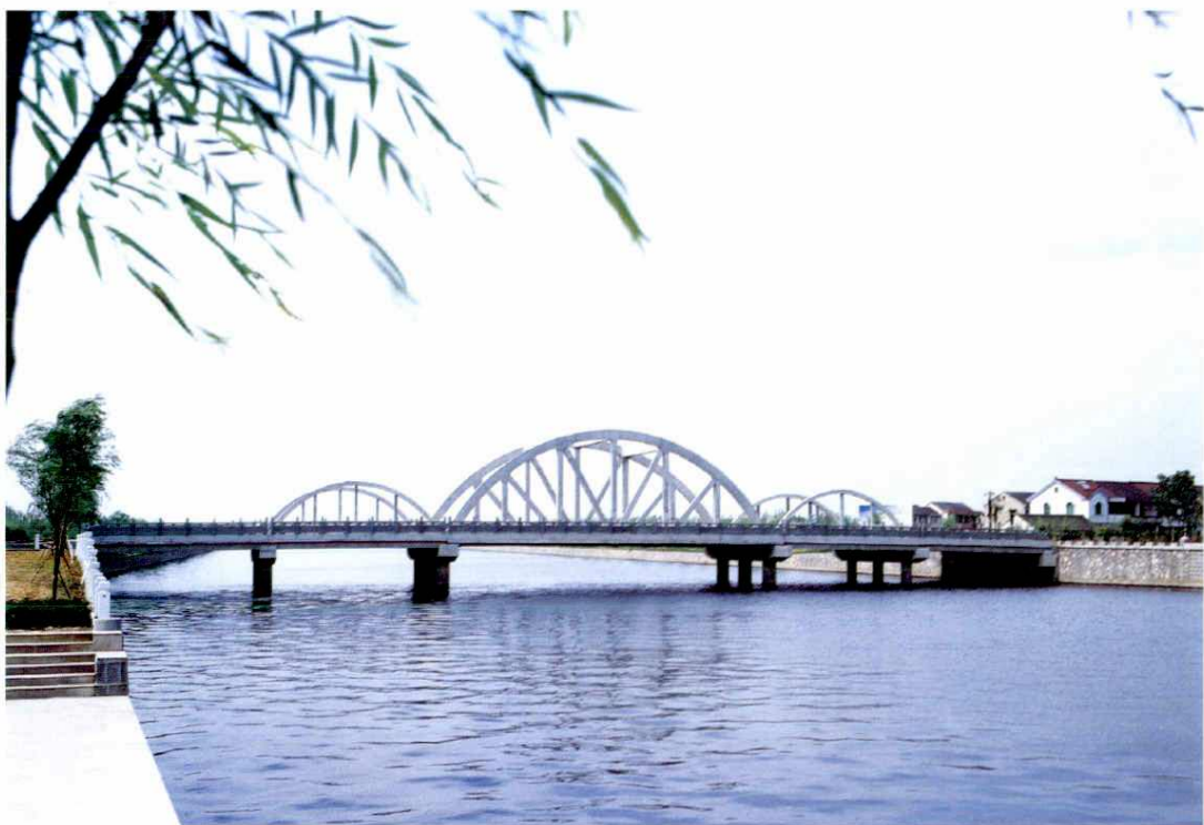
慈溪西部排涝工程一期陆中湾排涝河道，河面宽80米，长11.7公里
