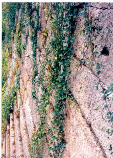
镇海古海塘 始建于唐昭宗乾宁四年（公元897年），全长4800米。其中“城塘合一”的夹层石塘长1300米，塘宽14米，高5米，集防潮、御敌功能于一身。左图为“城塘合一”部分海塘，右图为斜坡塘体
