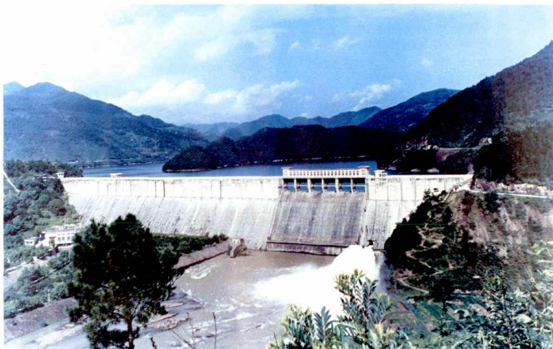
皎口水库 总库容11980万立方米，坝高67.4米，混凝土砌块石重力坝。以灌溉，防洪为主，兼发电，供水综合利用
