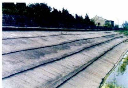
镇海古海塘 始建于唐昭宗乾宁四年（公元897年），全长4800米。其中“城塘合一”的夹层石塘长1300米，塘宽14米，高5米，集防潮、御敌功能于一身。左图为“城塘合一”部分海塘，右图为斜坡塘体
