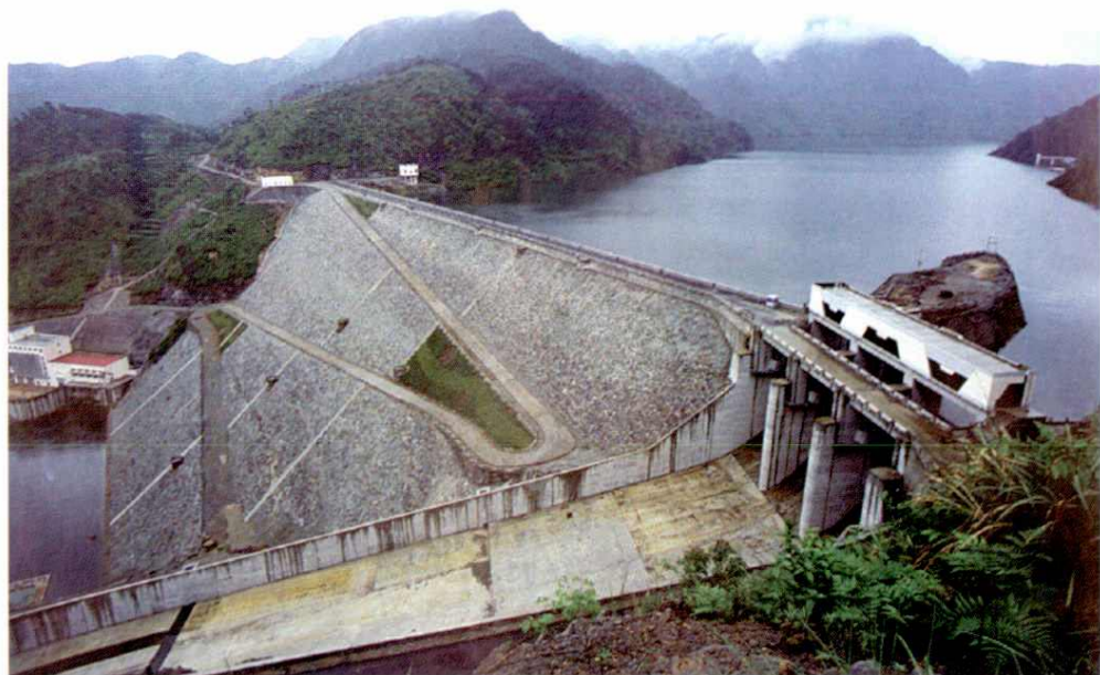
白溪水库 总库容16840万立方米，坝高124.4米，混凝土面板堆石坝。以供水、防洪为主，兼顾发电、灌溉，设计向宁波年供水1.73亿立方米，发电装机1.8万千瓦
