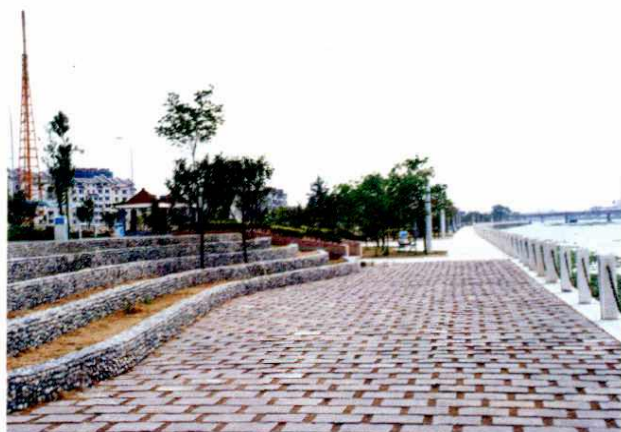
宁波市贺丞公园堤防工程
