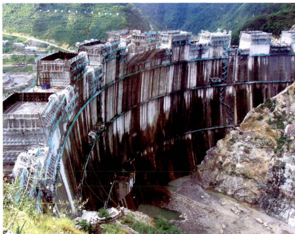
周公宅水库（2003年开工，正在建设中）设计总库容11180万立方米，坝高125.5米，混凝土双曲拱坝。以防洪、供水为主，兼顾发电
