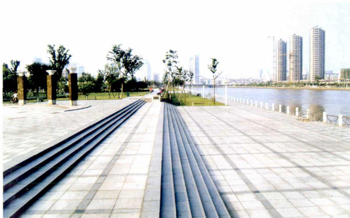
宁波市濠河公园堤防工程
