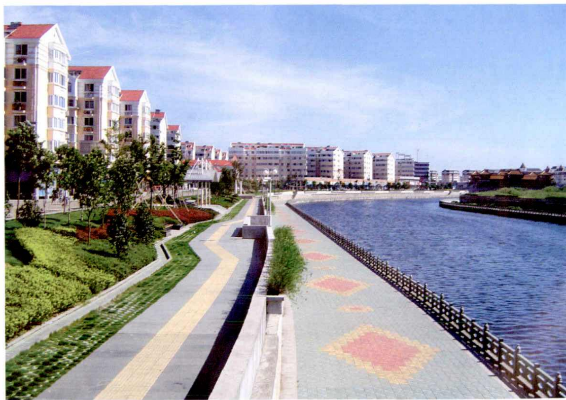
奉化市县江整治工程
