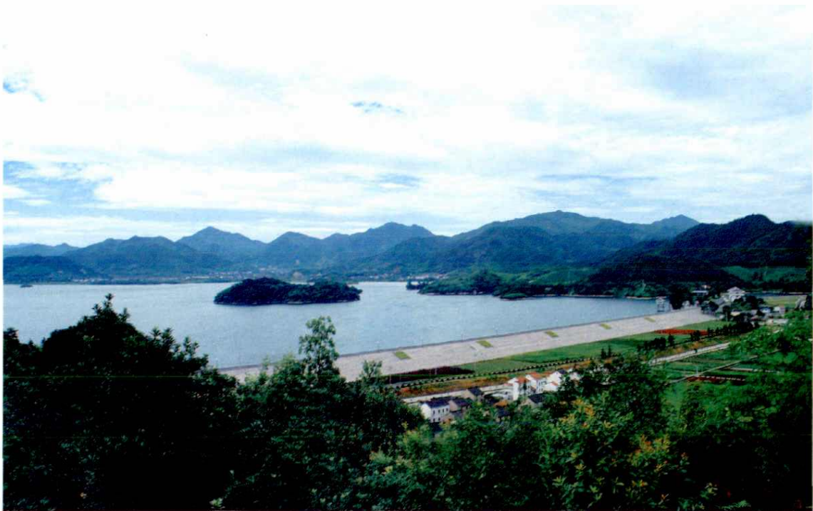
四明湖水库 总库容12272万立方米,坝高16.85米,粘土斜墙坝。以灌溉为主,兼防洪、发电、供水、养鱼等综合利用
