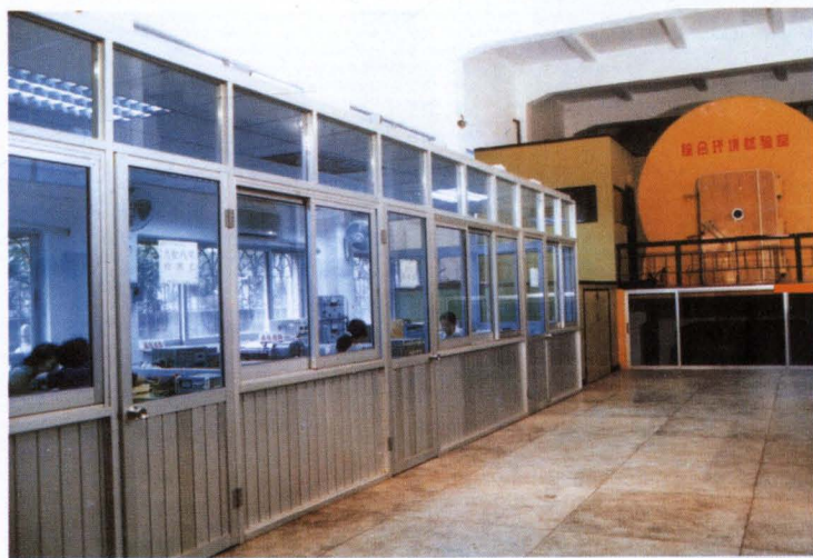
邮科所的总配线架、PTC热敏电阻、通信电缆检测室及综合环境实验室（摄于1994年）
