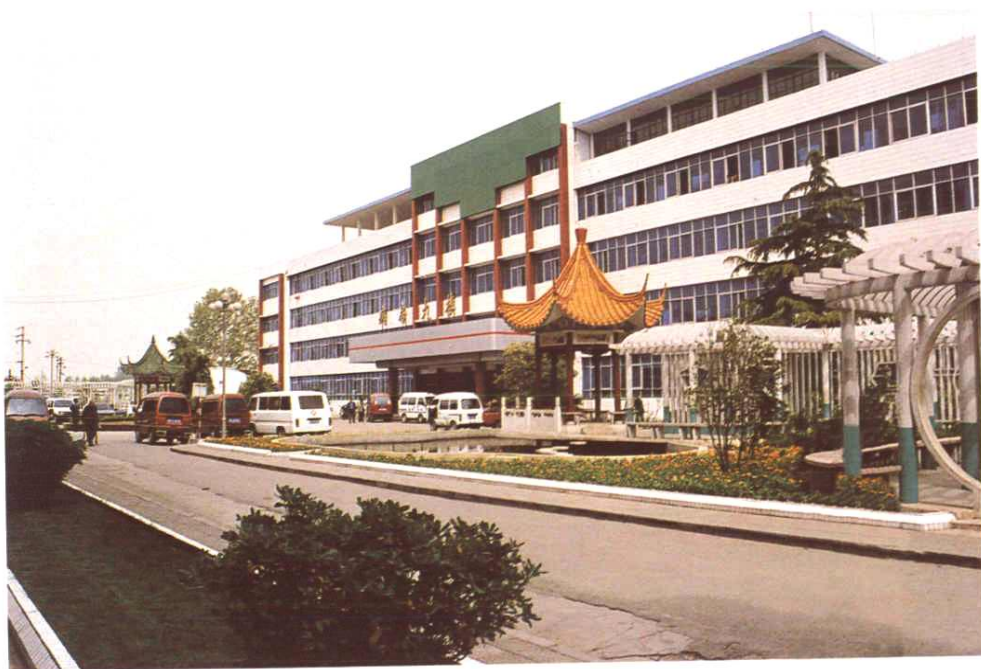
改造后的1号病房大楼
