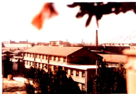
原住院部内、外科楼
