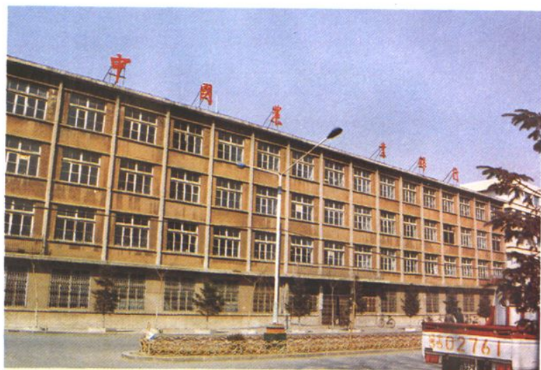
中国农业银行瓦房店市支行办公楼。
