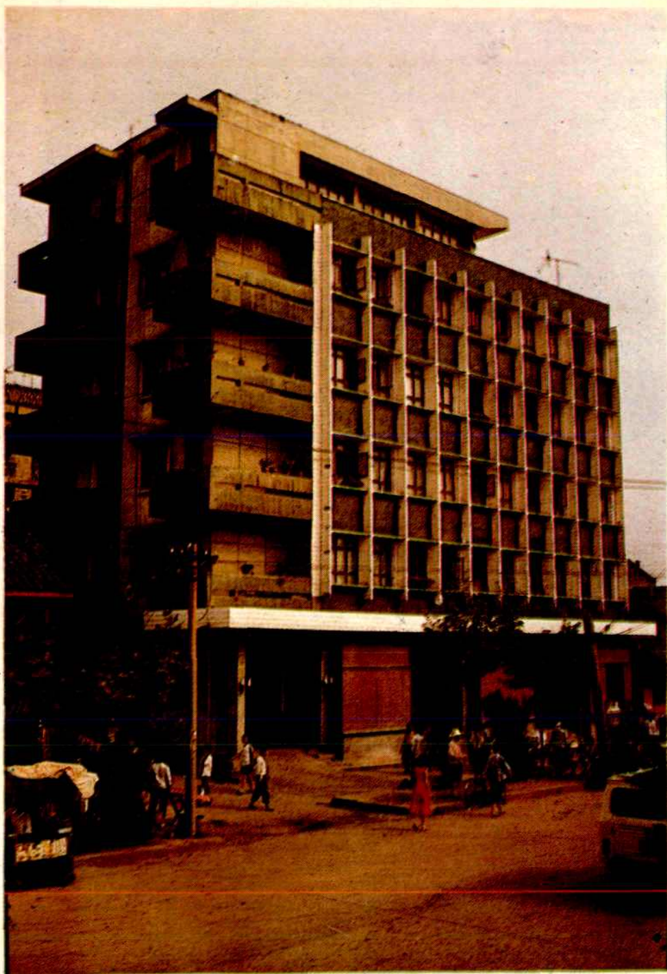
南充盐业分公司办公楼
