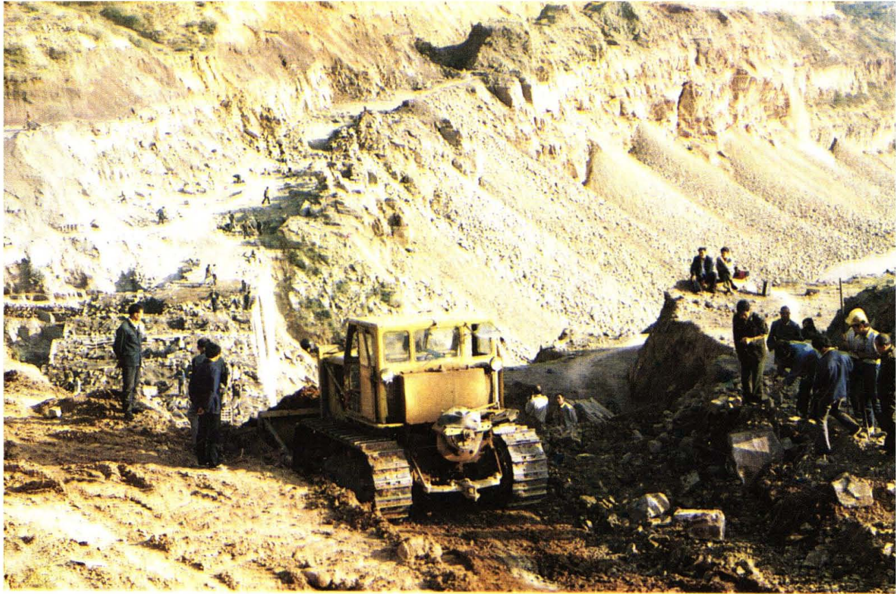
沁辉公路改建施工
