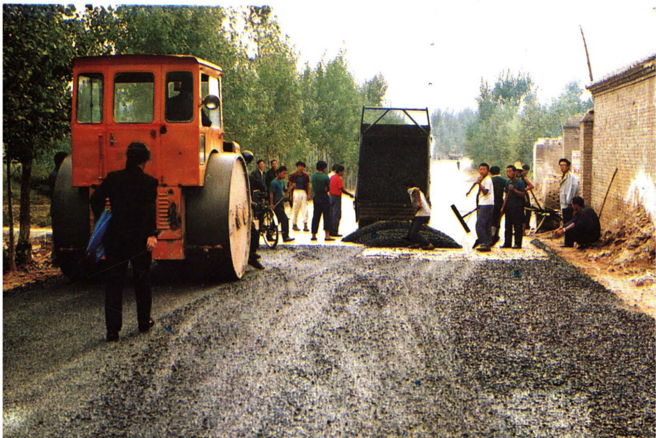
沁辉公路油路施工
