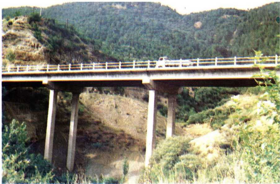
沁水县城北山高架桥
