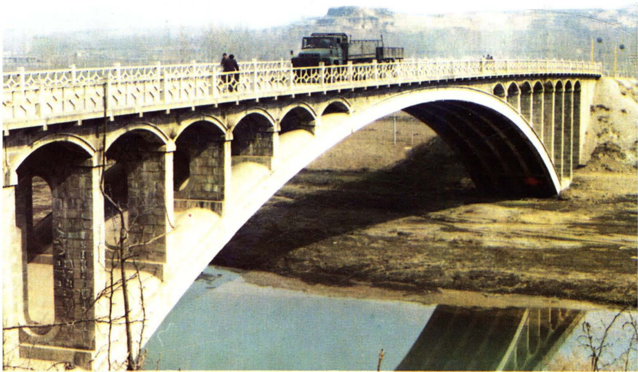
潘庄沁河大桥
