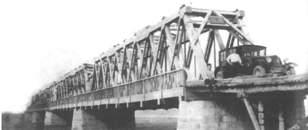
20世纪20年代末，位于太原城西门外南侧（今迎泽大桥以南约800米处）的汾河大木桥建成。该桥为木桁构大跨径石台墩木面桥，长780米。民国26年（1937年）11月日军入侵太原时毁于战火。
