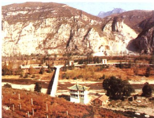
1957年10月30日，太原兰村水源工程竣工。这是当时全国利用地下水的最大给水工程。图为兰村水源地井群。
