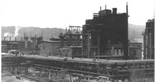
1954年7月，太原化工区开始建设，至1960年基本建成。图为化工区主体企业太原化肥厂一角。
