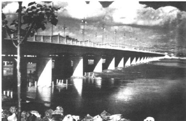
1954年元旦，汾河迎泽大桥建成通车。该桥为钢筋混凝土悬臂式桥梁，全长480.5米，宽15.4米。
