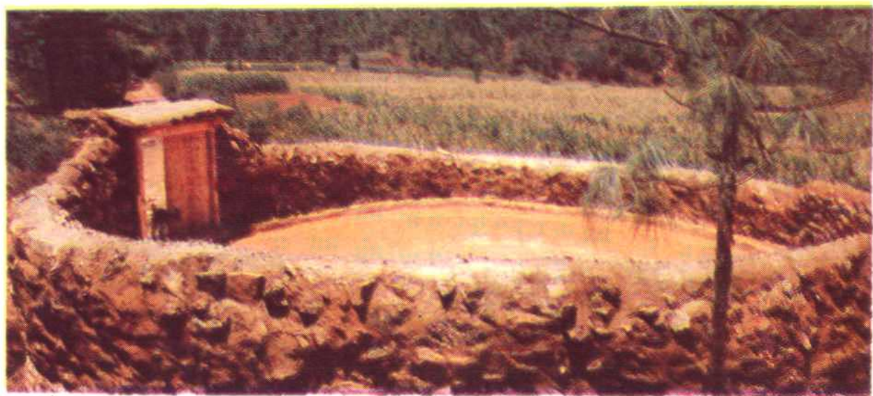
▲ 水浇地间修建的贮水池
