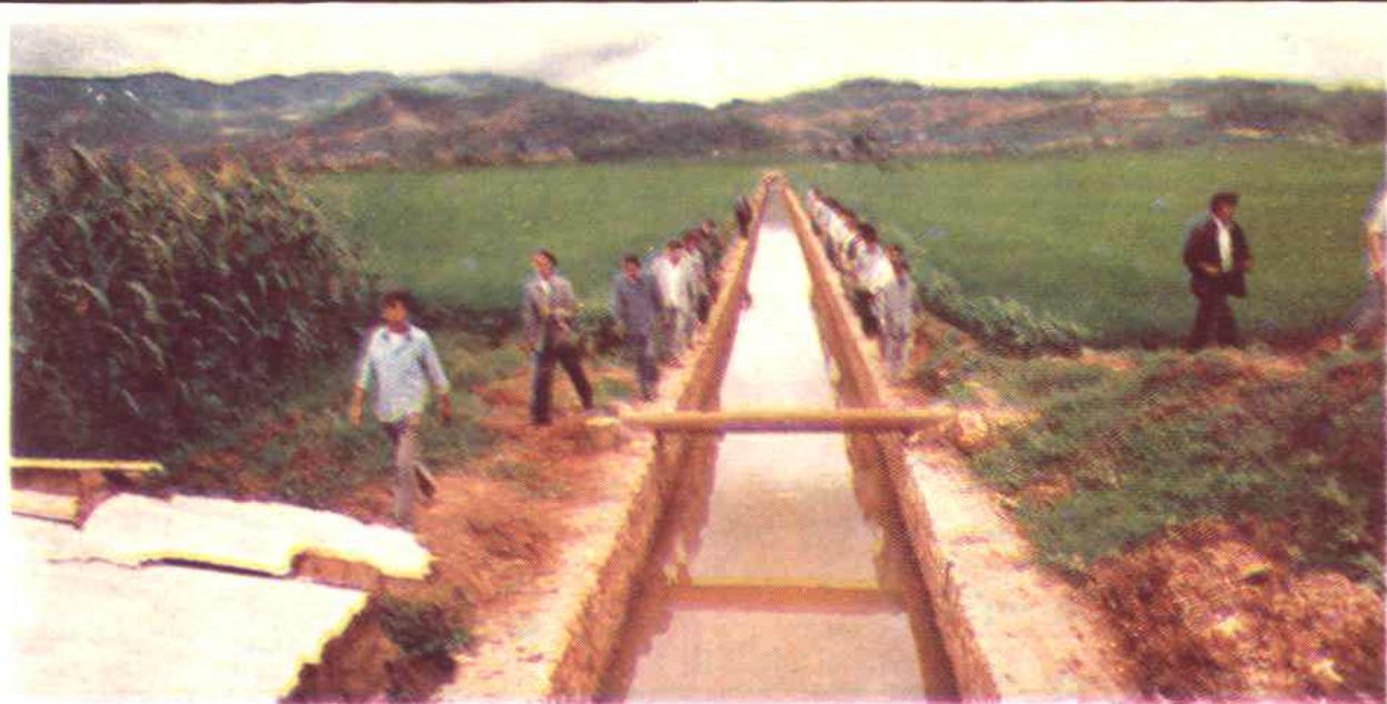
▲ 已建成的排水大沟
