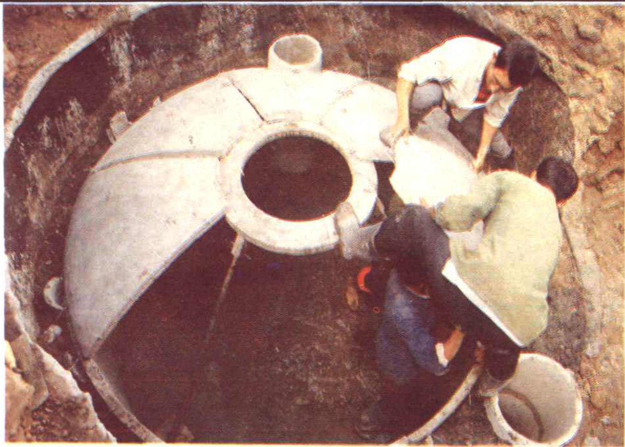
▲ 农村推广建造沼气池
