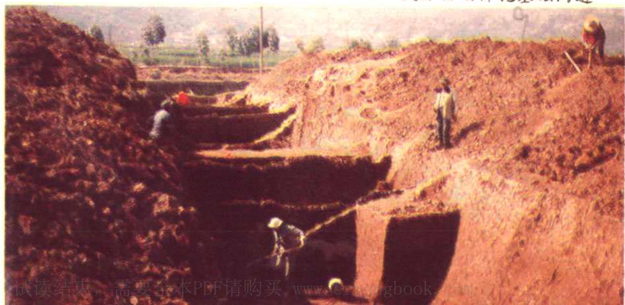
▼ 民办公助开挖基础沟道
