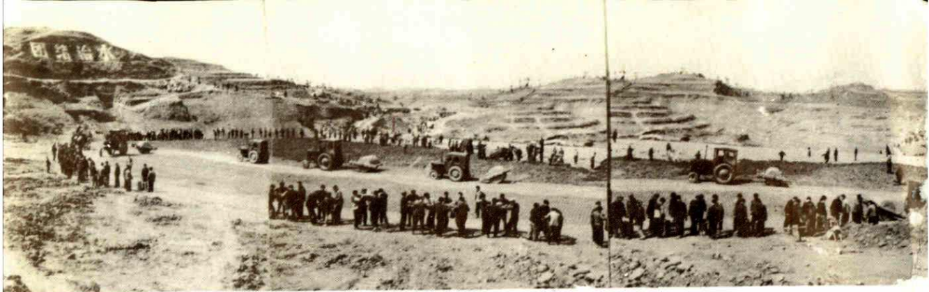
▲ 大佛水库大坝施工现场
