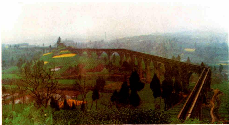
▲ 东林乡小沟渡槽
